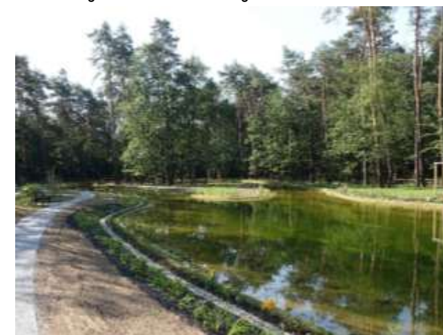
Foto 12 – Endzustand zur Teilabnahme Herstellung 08/2019
