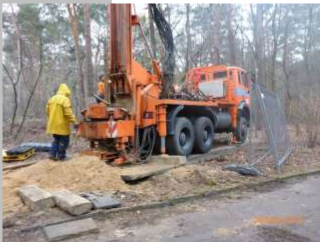
Foto 1 – Beginn Brunnenbohrung (Los 1) 03/2018
