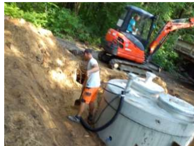
Foto 2 – Brunnen (Los 1) kurz vor der Fertigstellung 06/2018
