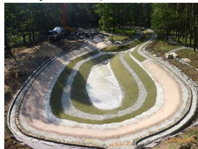
Foto 10 – Einbau des Mörtelpanzers 05/2019
