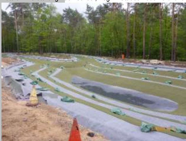
Foto 9 – vollständige Teichdichtung inkl. Verbundmatte 05/2019
