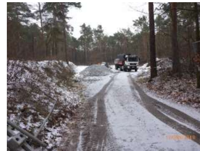
Foto 4 – Baubeginn Teich (Los 2) 01/2019
