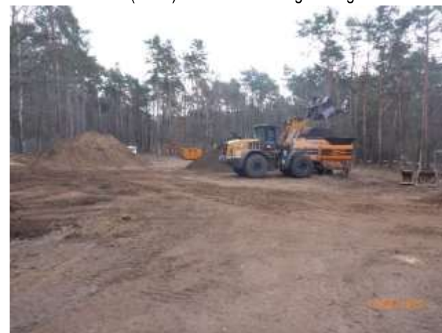
Foto 6 – Beginn Erdbau + Transport Überschussmassen 02/2019
