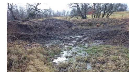
Baufeldfreimachung, Ablassen des Gewässers, Durchbruch im östl. Dam in Vorbereitung der neuen Überlaufrohrleitung
