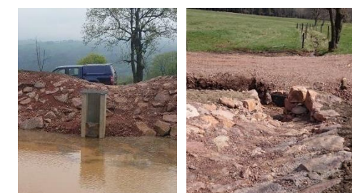
Details Teichmönch, Dammertüchtigung, Überlaufrinne sowie Rohrleitung unter Wirtschaftsweg
