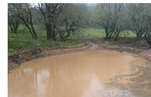
Abnahmestadium, Blick von Süden
