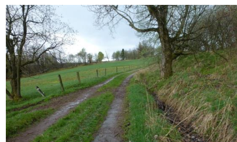
östl. Dammaußenseite im Bereich der auszutauschenden Überlaufrohrleitung
