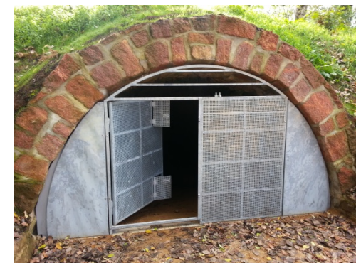
Gittertür mit variabler Beplankung (Sept. 2014)
