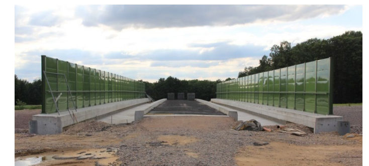
BW 31Ü mit Trogbauweise und blickdichter Kollisionsschutzwand
