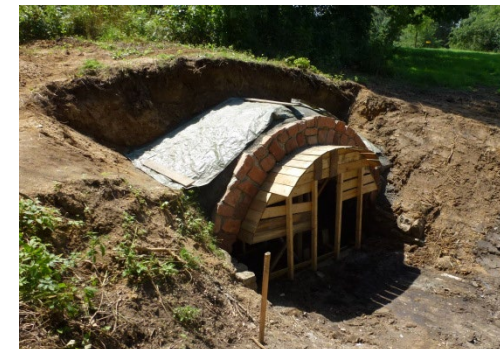
Sanierung Tonnengewölbe im vorderen Bereich
