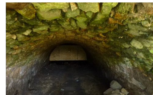
Einbau einer Holztür zur Trennung zwischen warmem und kühlem Quartierbereich
