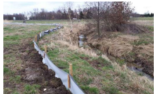
Zaunabschnitt 1 am Hofegrundbach / RRB 1, 03/2019
