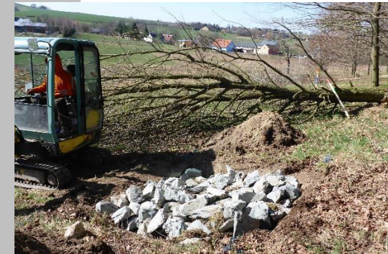
Herstellung kombinierter Strukturelemente, dabei Wiederverwendung des Holzes aus vereinzelt Freischnitt
