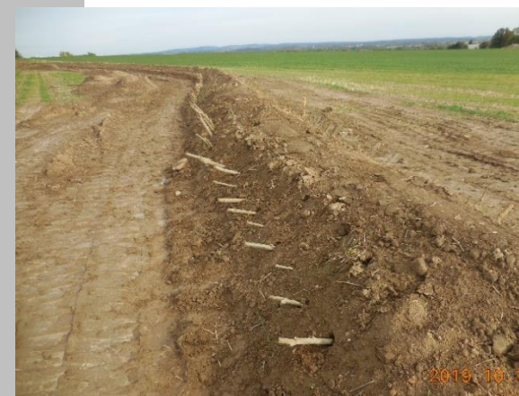
Einbau der Buschlagen in den Wall
