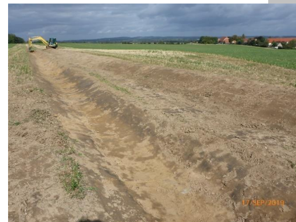
Herstellung Mulde und Profilierung Wall
